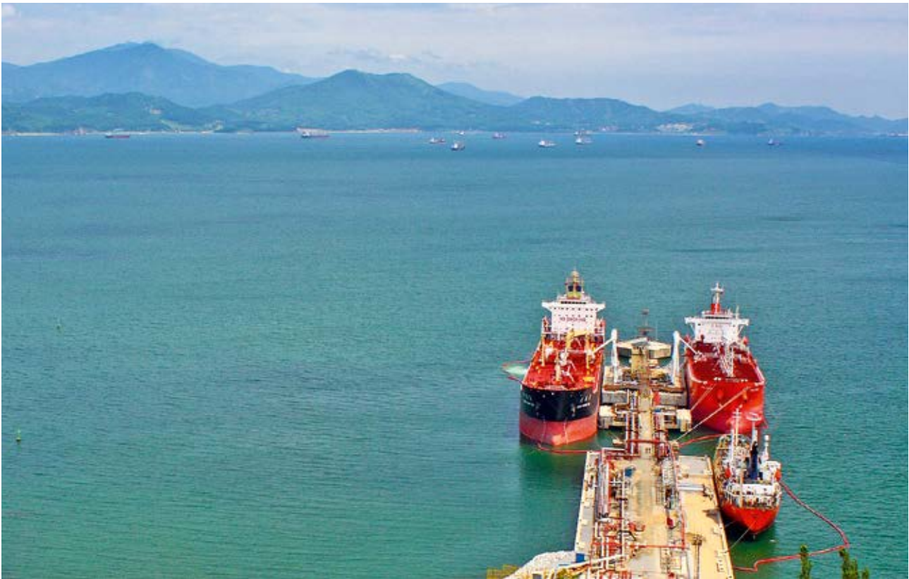
LLC RN-Nakhodkanefteprodukt sea terminal
